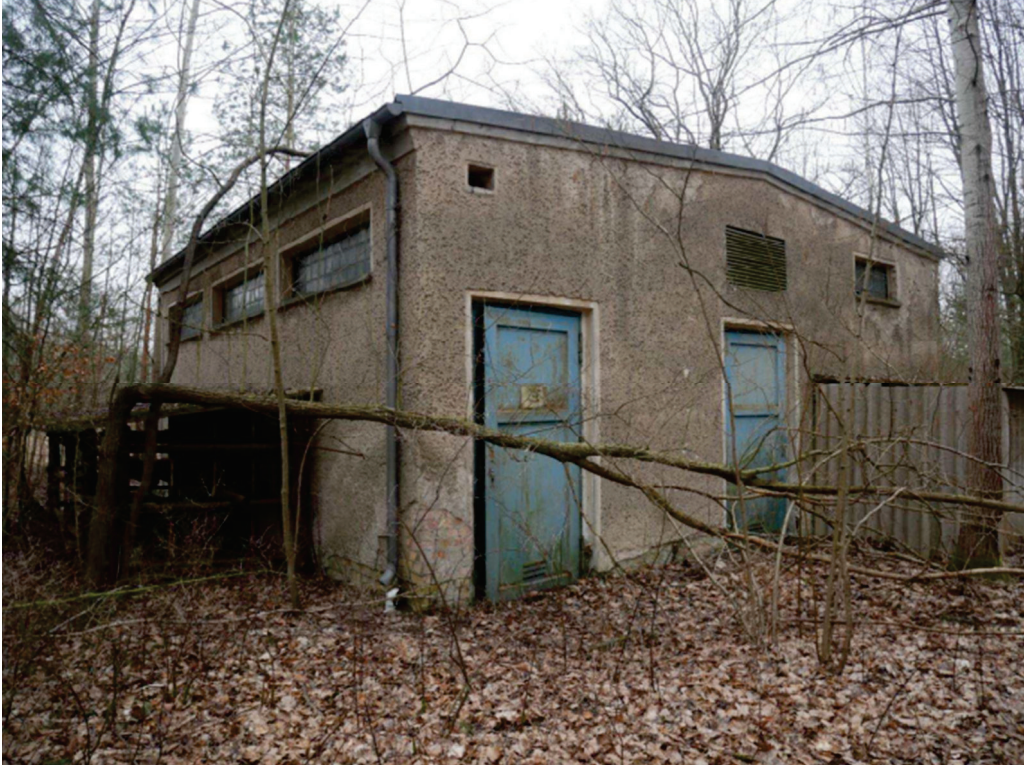
Abbildung 1: Gebäude 118 der Barnim-Kaserne Strausberg [3]
